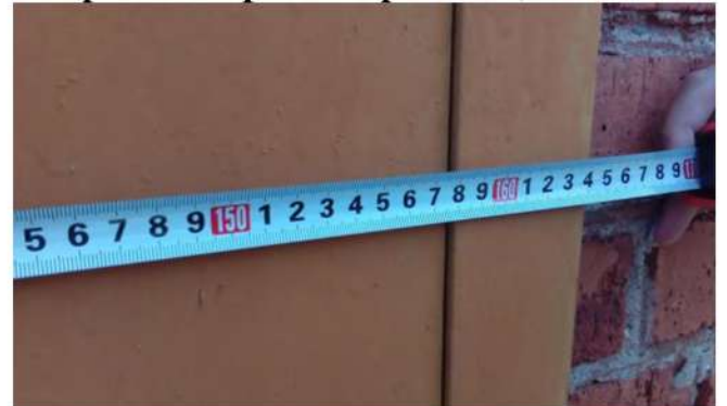
Ширина дверного проема 1,5м
