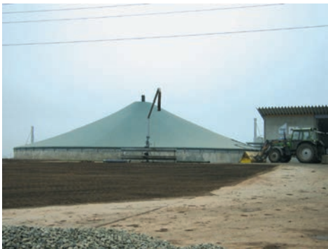
Рис. 1381 Признаком биогазовой установки является почти всегда колпак из полиэтилена над реактором. Под ним собирается биогаз.
